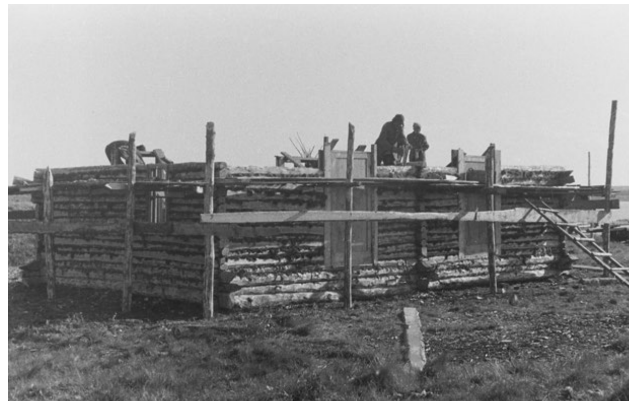
Строящийся дом из бруса. Возможно, станок Угарная
